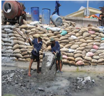
b) Bảo quản vật liệu tại công trường
